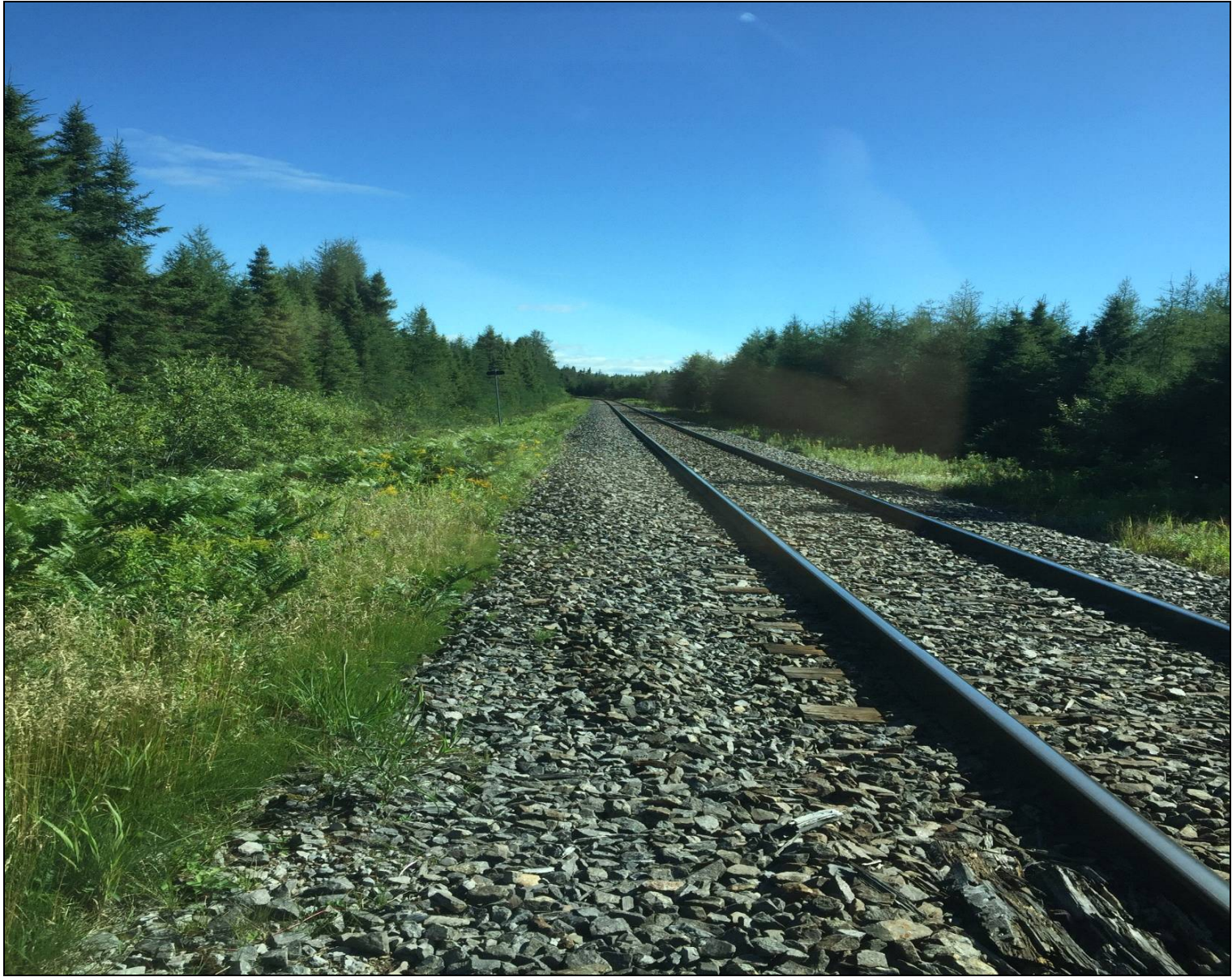
Photo de la voie ferrée.
